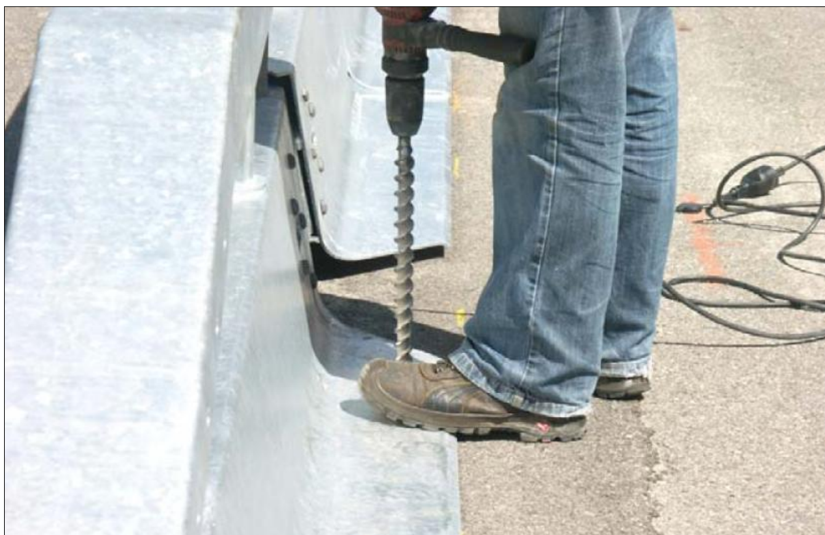
Vyvrtání otvorů vrtnou soupravou
