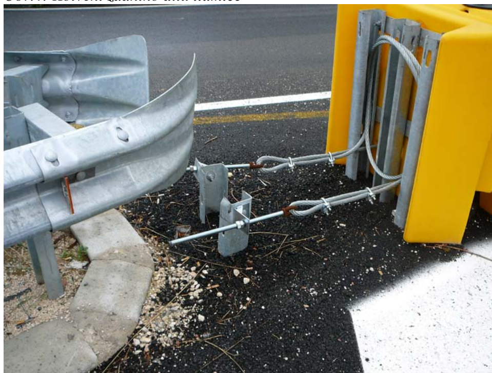
Obr.4: Kotvení zadního dílu tlumiče
