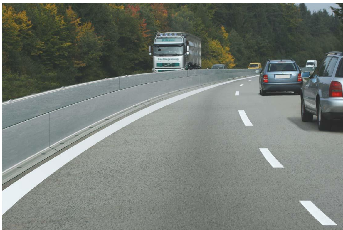
Obrázek 3 - Svodidlo Duorail – celkový pohled na osazené svodidlo
