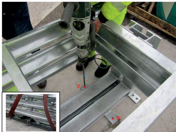
Obr.3: Vyznačení a vrtání otvorů O'_1 a O'_2
