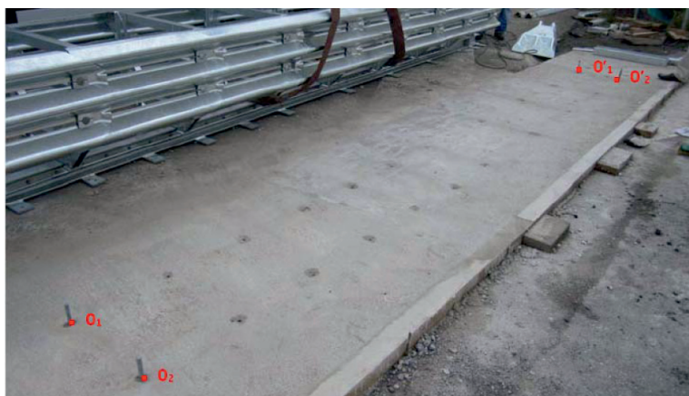
Obr.6: Základ s osazenými kotvami O_1 , O_2 , O'_1 a O'_2
