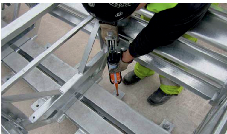
Obr.8: Dávkování pryskyřice do otvoru
