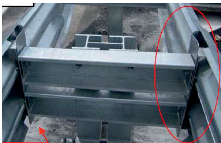
Obr. 11: Přechňvající část u přechodových svodnic AIR H110, H100P, H80P a H50P
