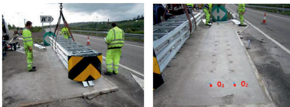
Obr.5: Odstranění tlumiče pro vyvrtání otvorů O_1 a O_2
