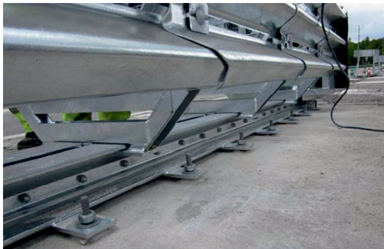
Obr.9: Osazený tlumič s kotvami před utažením matic
