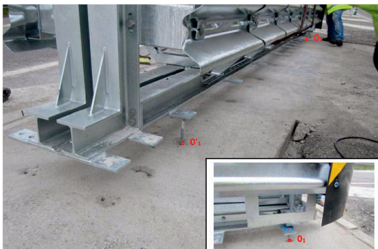
Obr.7: Osazení tlumiče
