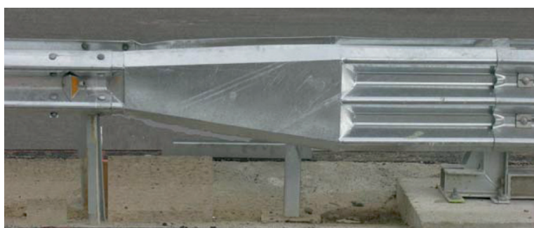
Obr. 12: Přechodová svodnice z třívlínné AIR H110/100/80/50P na dvouvílnnou tvaru W
