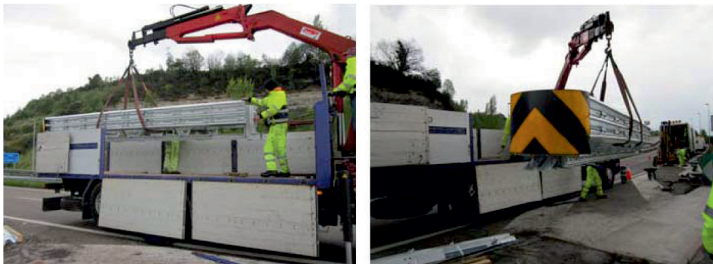
Obr.2: Vyložení tlumiče nárazu AIR H110P
