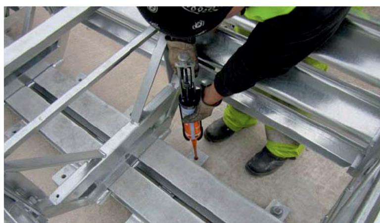
Obr.8: Dávkování pryskyřice do otvoru
