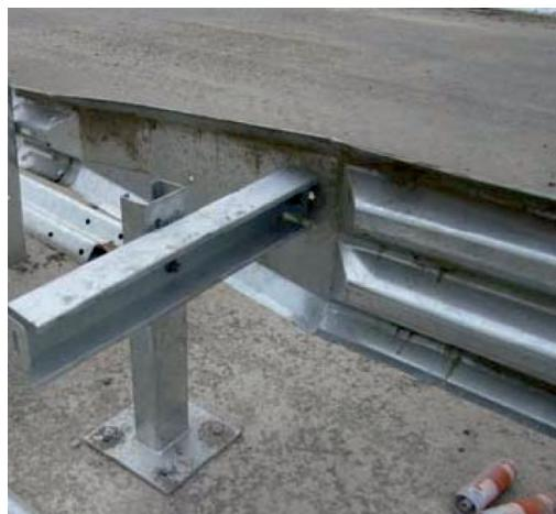
Obr. 10: Podstavec přechodové části svodidel C-125 se základovou deskou
