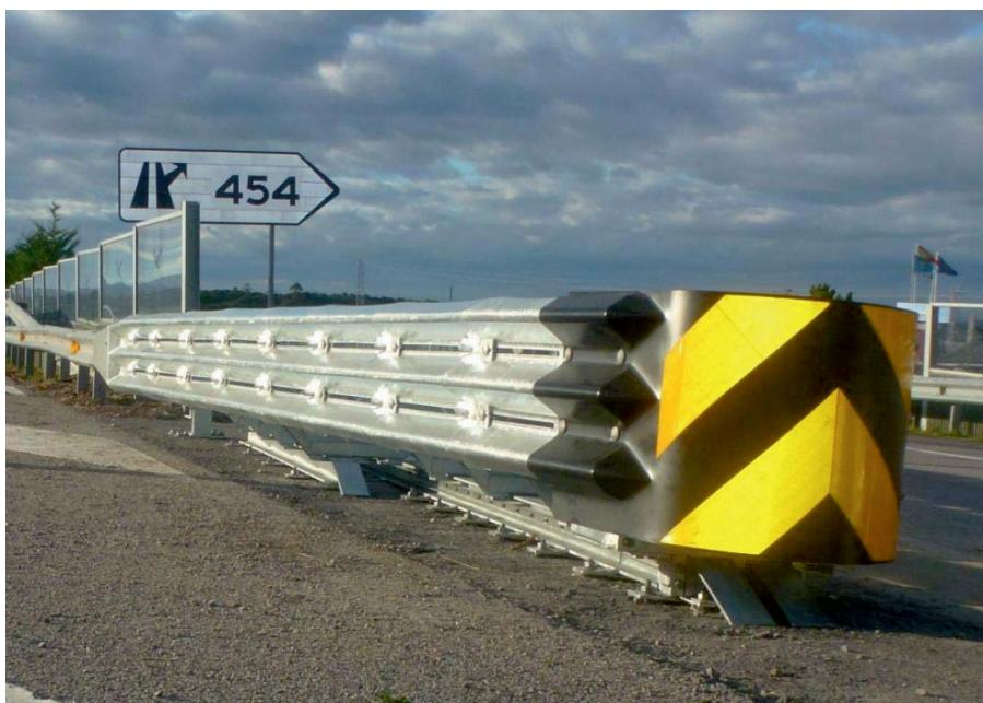
Obr.9: Osazený tlumič s kotvami před utažením matic
