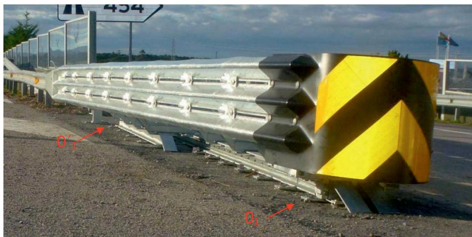
Obr.6: Umístění kotevních desek v bodech  $O_1$  a  $O'_1$
