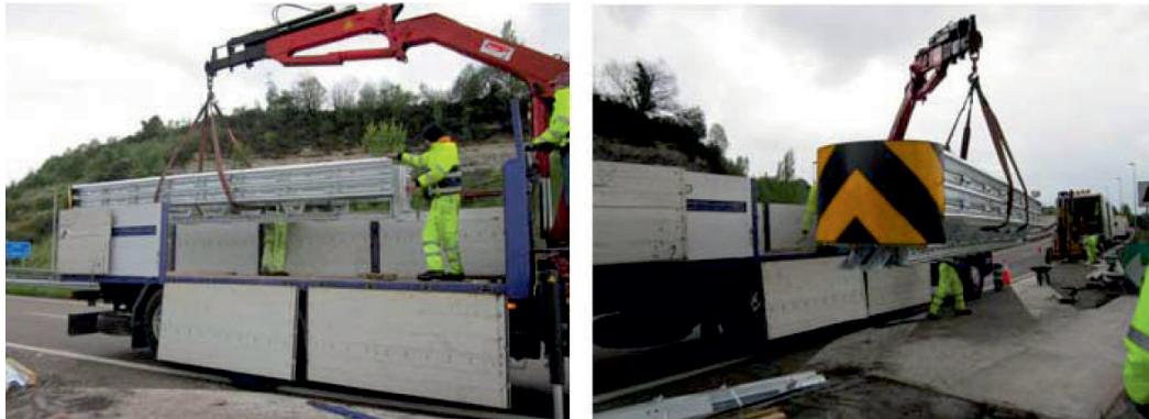
Obr.2: Vyložení tlumiče nárazu AIR H
