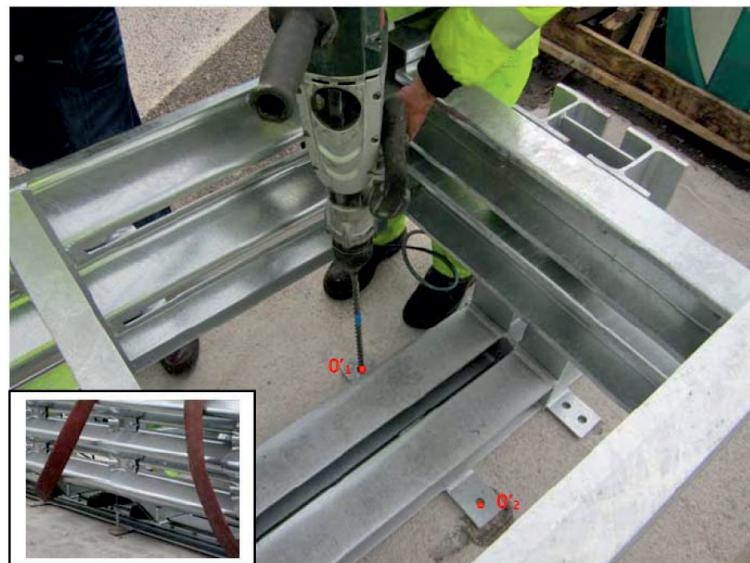
Obr.3b: Vyznačení a vrtání otvorů  $0'_1$  a  $0'_2$
