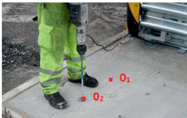
Obr.5: Odstranění tlumiče pro vyvrtání otvorů  $O_1$  a  $O_2$
