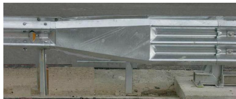
Obr. 12: Přechodová svodnice z třívlnné AIR H110/100/80/50V na dvouvlnnou tvaru W
