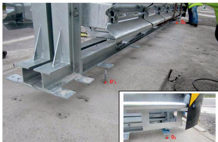
Obr.7: Osazení tlumiče
